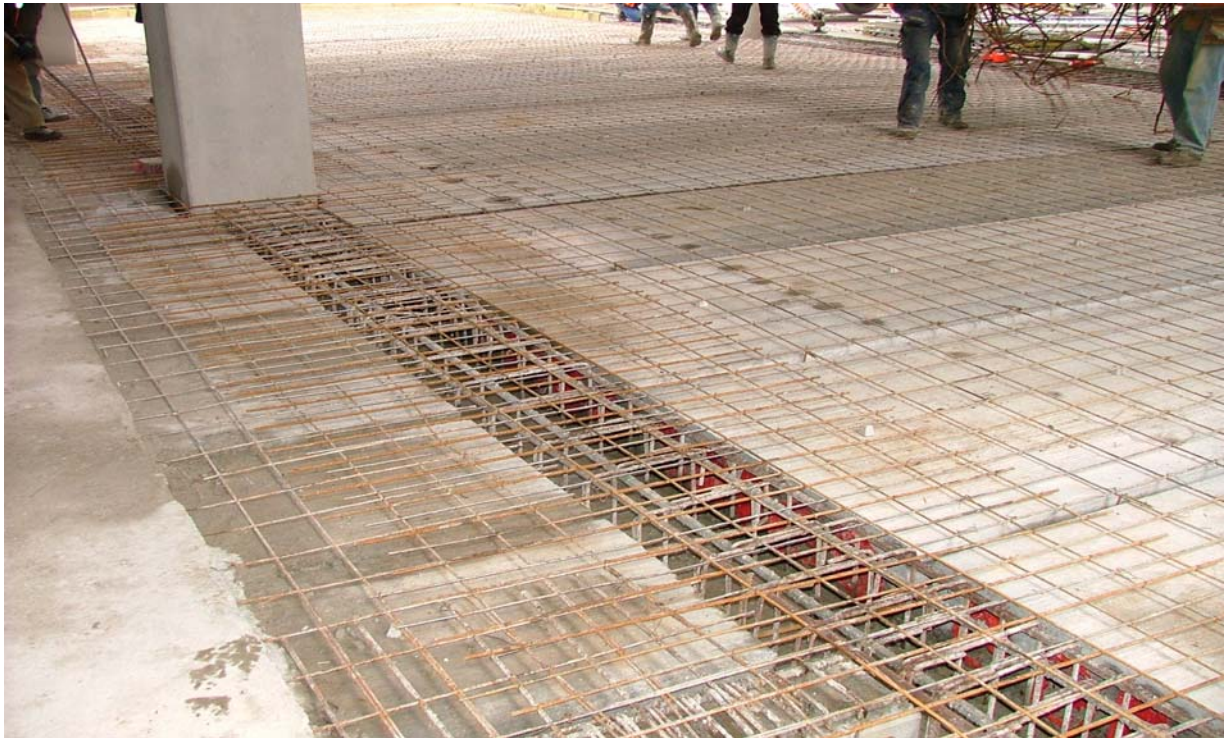
Obr. 2: Stropná konštrukcia pred monolitickou dobetónavkou
