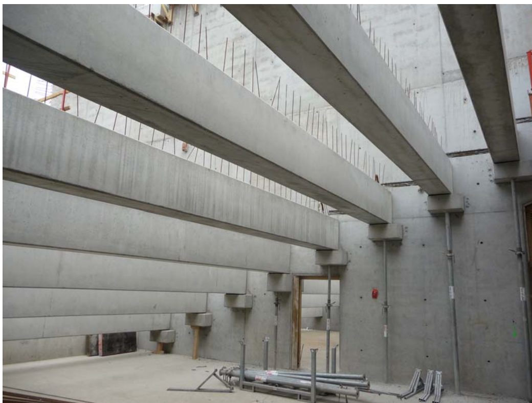
Obr. 3: Stropná konštrukcia hľadísk v časti KINO
