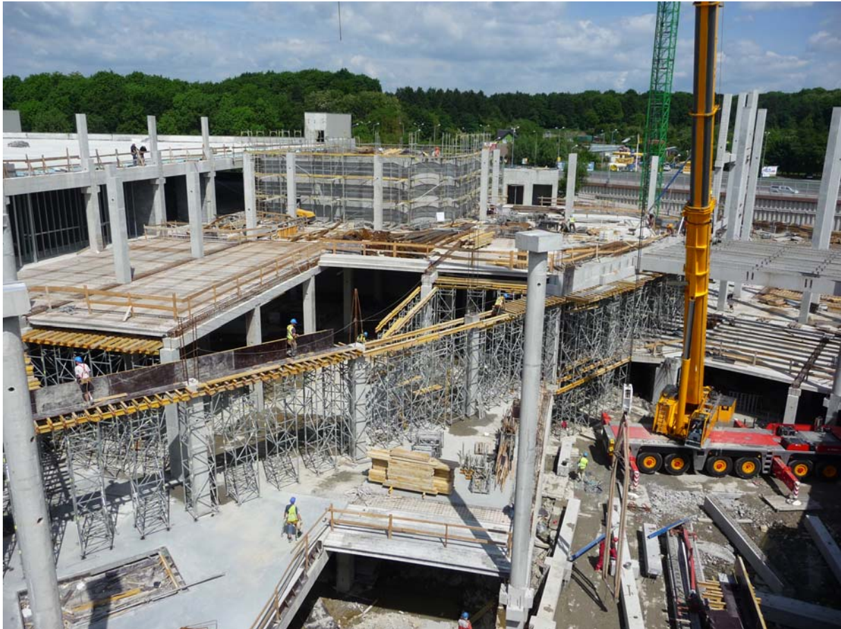
Obr. 5: Montáž prefabrikovanej konštrukcie
