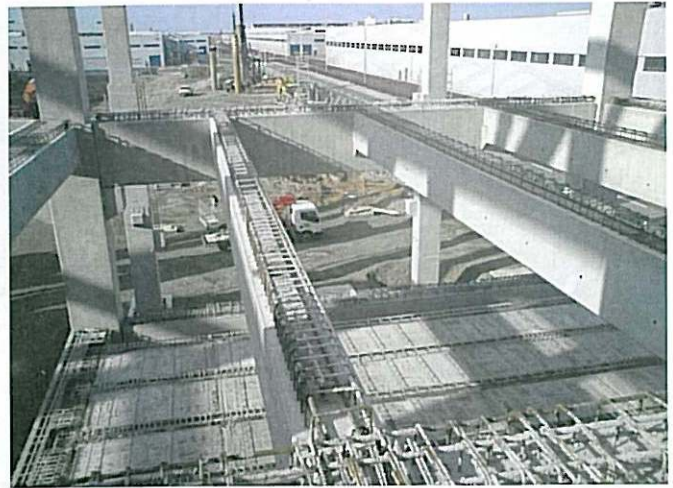
Bild 7. Stahlbetonunterzug mit Rippenbalken
