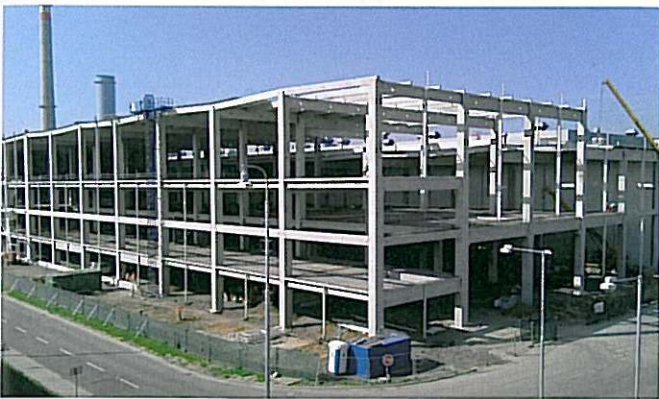
Bild 3. Fortgeschrittene Tragwerksmontage der Halle 2A
