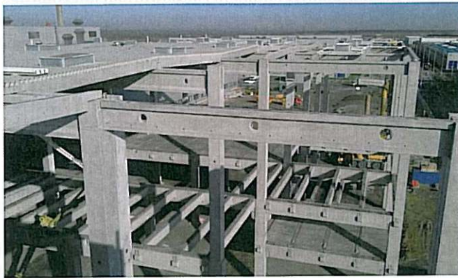
Bild 6. Stahlbeton-Fertigteilbinder und -Pfeifen
