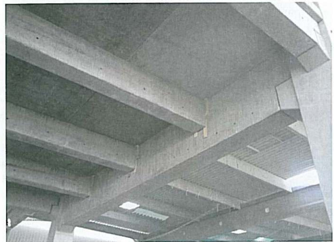
Bild 8. Verlegte Filigranplatten
