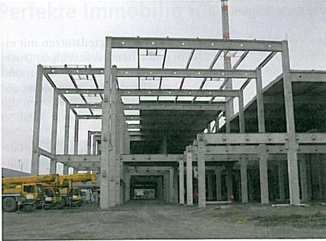
Bild 5. Vorgespannte, 24,0 m lange Fertigteilbinder
